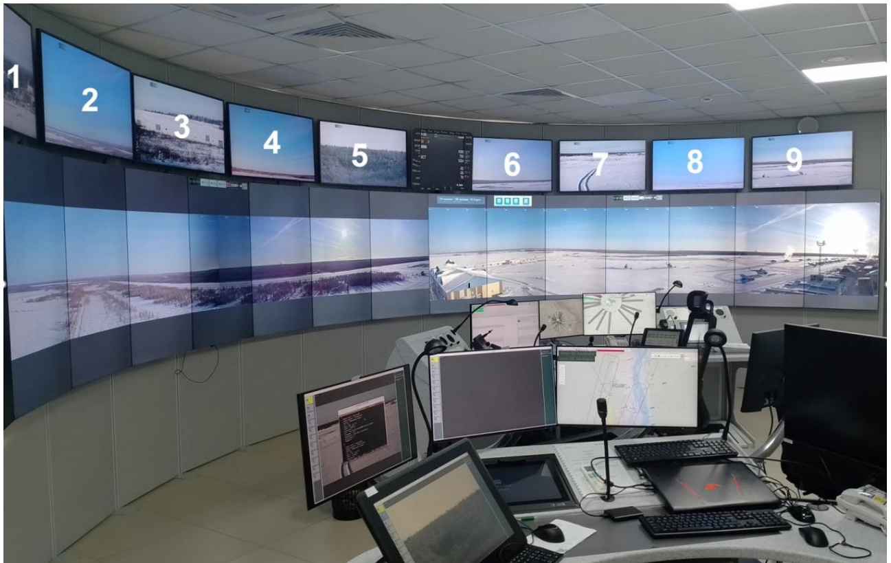
Рисунок 2. Схема размещения мониторов над конструкцией видеопанорамы.
