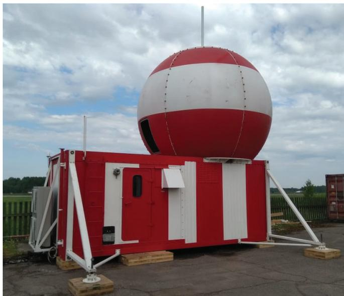
Аппаратура передачи данных АРЛК обеспечивает трансляцию в два центра обработки радиолокационной информации в форматах АСТЕРИКС категории 1, 2, 34, 48, информацию о целях режимов RBS, и целях, наблюдаемых по первичному каналу.
