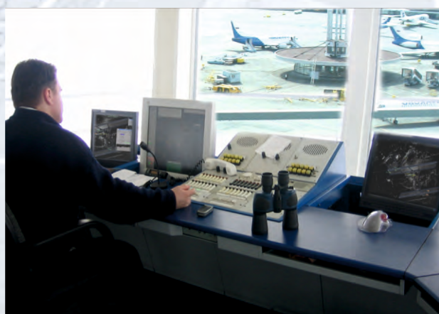
Пульт диспетчера с оборудованием КСА НКВД «Вега» в аэропорту Пулково
