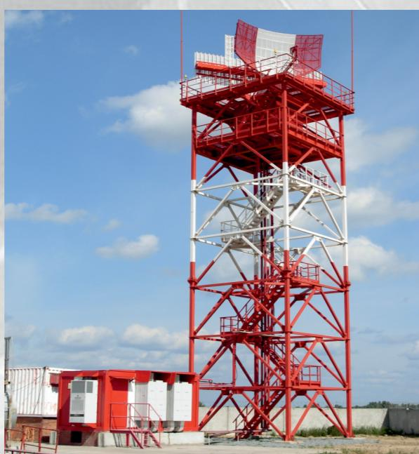
**Антenna система** формирует двулучевую диаграмму направленности. Антенна МВРЛ размещается на одном ОПУ с антенной ПОРЛ и развернута относительно антенны ПОРЛ на 180°.
